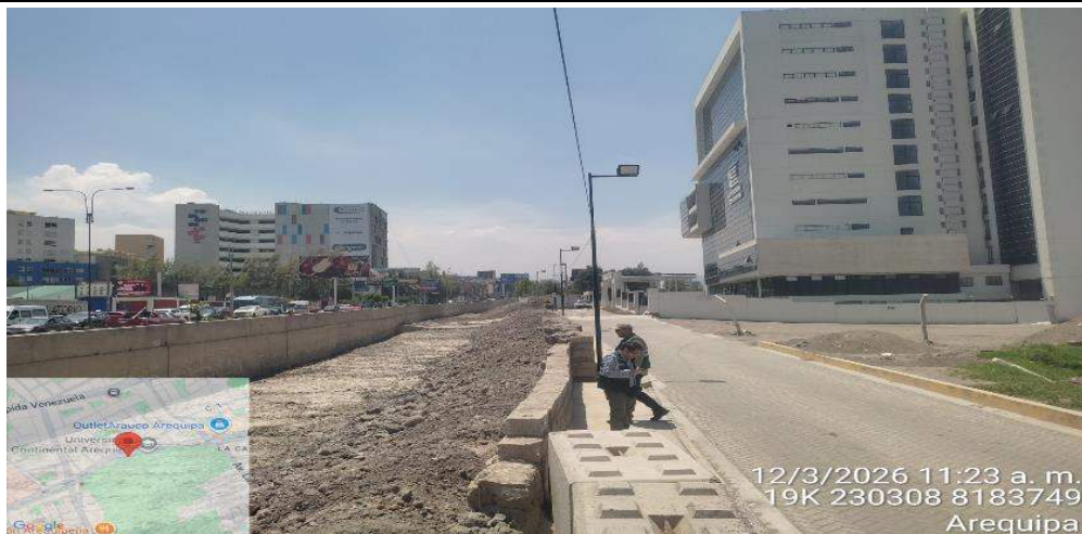
IMAGEN 01: SE OBSERVA LA QUEBRADA LOS INCAS EN LA MARGEN IZQUIERDA SIN PROTECCION EROSIONADO CON LA AVENIDA DEL MES DE FEBRERO EN EL SECTOR UNIVERSIDAD CONTINENTAL AGUAS ARRIBA
