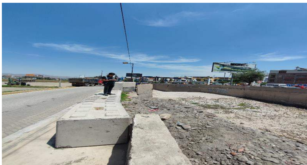
IMAGEN 02: SE OBSERVA LA MARGEN IZQUIERDA EN EL TRAMO FINAL QUE REQUIERE DE UN MURO DE CONTENCIÓN Y EVITAR EL DESBORDE Y AFECTACIÓN A VIVIENDAS, FAMILIAS Y CULTIVOS AGUAS ABAJO
